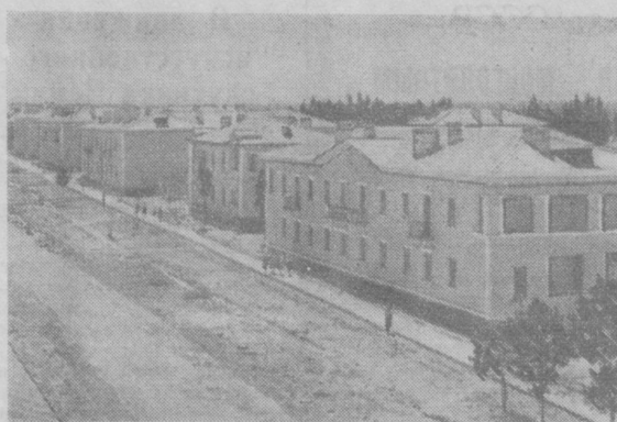
Ферганская область. Сотни квадратных метров жилой площади ежемесячно получают рабочие Ферганского нефтеперерабатывающего завода. Горючее нефтяников непрерывно разрастается. На снимке: новые жилые дома в городке рабочих Ферганского нефтеперерабатывающего завода.
