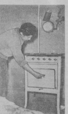
На снимке: газовая плита, установленная в квартире Л. И. Плякиной.
