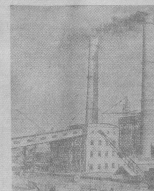
На снимке: общий вид строительства Ангренской ГРЭС.
