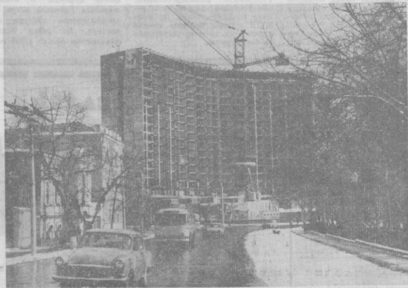
ТОШКЕНТ МАКНАСИДА «ЎЗБЕКИСТОН» МЕХМОНХОНАНИНГ ҚУНА БУЙ ҚЎЗГАН БИНОСИ ҚАД КЎТАРДИ. УН ЕТТИ ҚАВАТИН. БУ БИНО МЕТАЛЛА ТЎСИНАЛАРИНИ МОНТАЖ ҚИЛИШ ТУГАЛЛАНДИ. УНН ҚУРИШДА 26 ТА БРИГАДА ИШЛАЯПТИ. ПАРДОЗЧИЛАР ҲАМ ИШ БОШЛАБ ЮБОРИШДИ. СУРАТЛАРДА: ҚУРИЛА.
