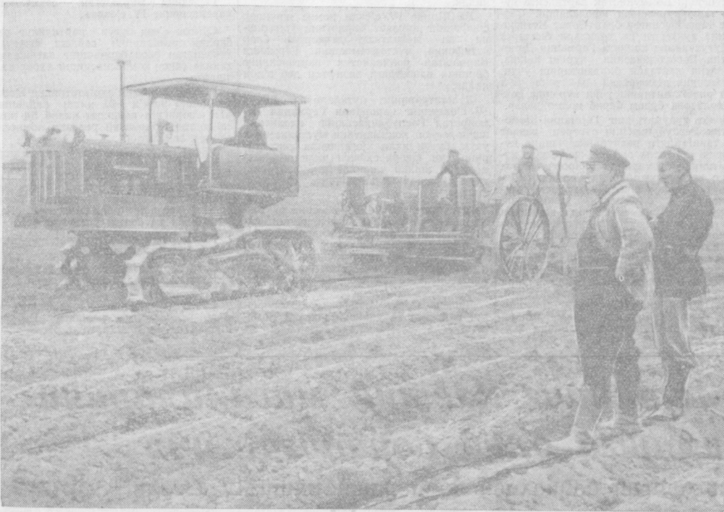
Областимиз қолхозларида картошка ҳўжалик машиналари ишлатилмоқда. Драт шаклида уялаб экиб 300 киши блан қолхозда СКГ-4 марнали машина
