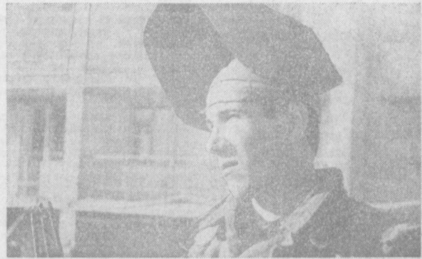
Шаҳримизда уй-жой қурилиш ишлари давом этмоқда. 6-трестга қарашли 29-қурилиш бошқармасининг бунёдкорлари бу борада яхши муваффақиятларни қўлга киритишляпти. Т. Ягодин шу бошқарманинг энг моҳир электр пайвандчиларидан ҳисобланади. Сурагда: Т. Ягодин иш устида. А. Тўхтасинов фотоси.
