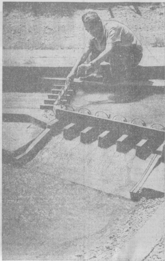
Ўрта-Осиё ирригация илмий текшириш институтига янги ирри-гация қўрилиш лойиҳалари синаб кўришмоқда. Бу сурат институт лабораторияларининг бирида олишган. Унда инженер-ирригатор То-ҳир Мирпўлатов тоғлиқ зоналарига қўлавиладиган сугориш моде-лини синаб кўрмоқда.
