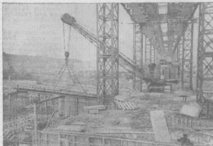
Иркутск гидроэлектростанцияси қурилишида. М. Минеев фотоси (ТАСС фотохроникаси).
