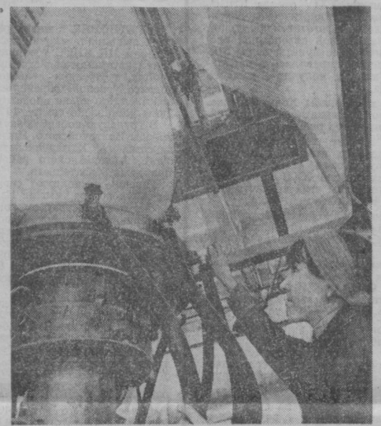
Продукция Джизакского завода пластмассовых труб идет на строительство ирригационных и мелиоративных сооружений на целинных землях Голодной степи. Уже выпущен первый миллион квадратных метров полиэтиленовой пленки. На снимке: Наталья Худякова работает оператором на установке производства полиэтиленовой пленки.
