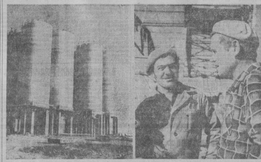
Первая очередь Навоййского цементного завода — директива строителей — должна войти в строй в конце будущего года. Это предприятие станет гигантом цементной индустрии. Его проектная мощность составит 2,200 тысяч тонн продукции в год. Строительство нового цементного завода успешно ведет коллектив строителей СМУ-9 Навоййского управления строительства. По всем показателям план десяти месяцев выполнен досрочно. Коллектив СМУ-9 соревнуется со строителями Карагандинского цементного треста «Металлургстрой». На снимках: слева — завершено бетонирование двух блоков склада цемента, состоящих из восьми башен диаметром 12 метров; справа — передовые крановщики Антон Луя (слева) и Анатолий Истокин.
