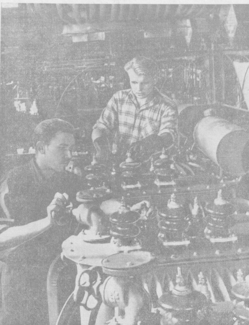
Чирчиқдаги электр машинасозлиги заводининг коллектив янги трансформатор подстанцияси комплекти ишлаб чиқаришни ўзлаштирди. Бу подстанциялардан кон-руда саноати корхоналарида фойдаланилади. Суратда: мастер В. Савельев (чапда) ва монтер А. Васюкович ўртоқлар тайёр трансформаторларни қўздан кечирмоқдалар.
