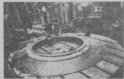
Будапештдаги «Ланг» заводига қуввати 100 мегаваттга тенг келадиган гигант турбина қурилмоқда. Ушбу суратда сиз инженер Эри Керекешнинг ўрнатилган роторни солаётганини кўриб турибсиз.
