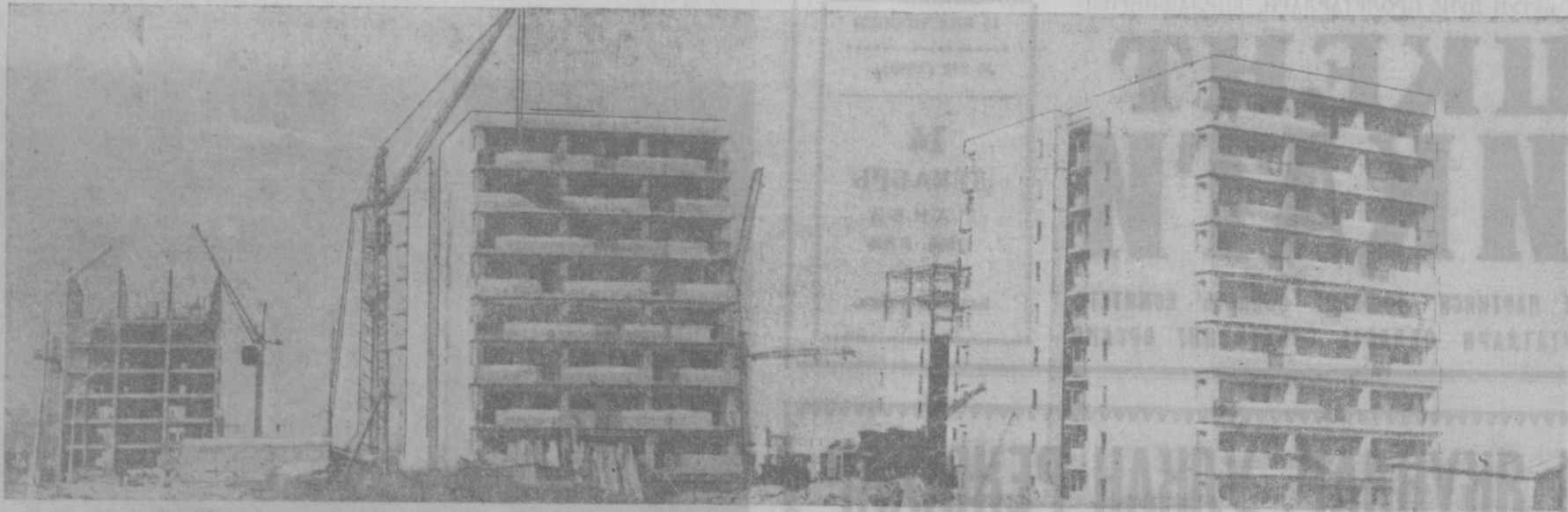
Чилонзор районининг 23-кварталида замонавий типдаги бир неча ягли уйлар тикланмоқда. Бу уйлар аввалдагиларига қараганда бириунча устуналикара — эга ва қурилиш жараёни ҳам бироз ўзгача. Бундай туққиз қаватли уйлар бешқа кукунар биноларга нисбатан фарқи унинг металл сич ва қаттиқ амурагага эгалтидир. Хар бир уй икки секциядан иборат. Хоналари ёруғ ва кенг. Сурат — М. Баржанов фотоси, (ЎзТАГ).
