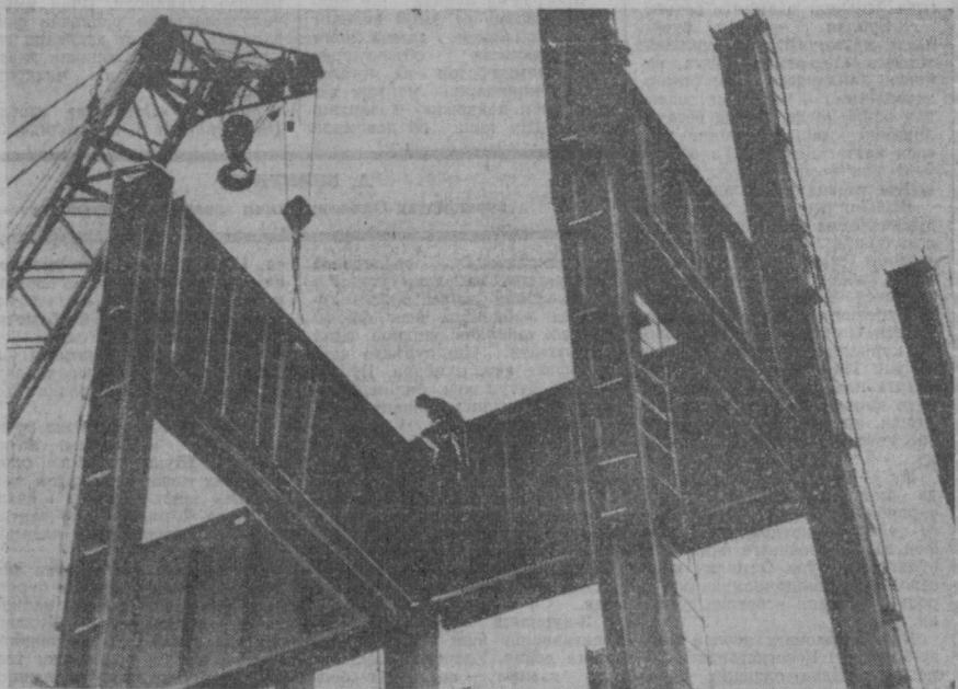
«СТАЛЬМОНТАЖ» бошқармаси коллективи фосфорит экстракция қилиш цехининг металл-конструкцияларини монтаж қилишмоқда. Суратда: фосфорит экстракция қилиш цехининг бир қисми. А. Тўраев фотолари.
