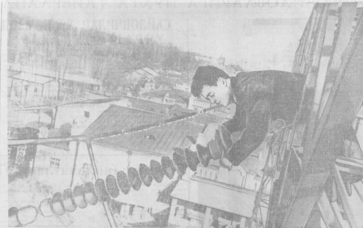
Наби Зокиров Ўзбекистон ССР Фанлар академиясининг энергетика ва автоматика институтда яшашини илмий ходим бўлиб ишлабди. Суратда: ўртоқ Н. Зокиров электр линияларидан изоляциялар устида текшириш олиб бормоқда.
