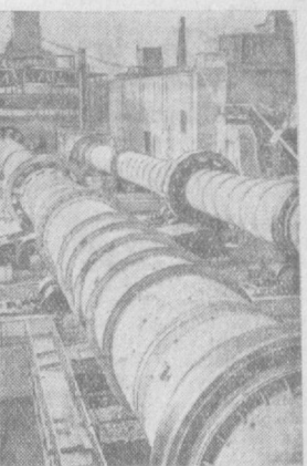
Суратда: Бекобод цемент комбинатида монтаж ишларини янши айланиа печлар. Р. Шамсуддинов фотоси. (ЎзТАГ фотокорреспонденти).
