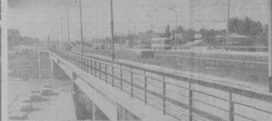
Чилонзор районининг «Халқлар дўстлиги» проспектида янги магистрал кўприк қурилиб фойдаланишга топширилди. Суратда: янги кўприкнинг умумий кўриниши. М. Нуриддинов фотоси.
