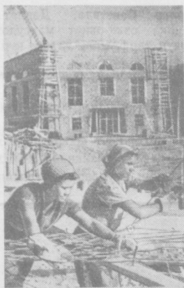
Оқатларондаги ерости газ станцияси қурилиш ишлари суръатда олиб боришмоқда. Суратда: қурилиш топшириқини 180 процентга етказиб бажарётган илгор монтажчилардан (чапдан) Т. Фини-накская ва В. Сильнова ўртоқлар иш устиди.
