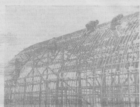
Электр станция қурилишида минглаб тонна арматура монтаж қилиняпти. Суратда: ўртоқ Ю. Лижов-бригадаси арматура қарқасини йиғмоқда. Н. Третьяков фотоси.
