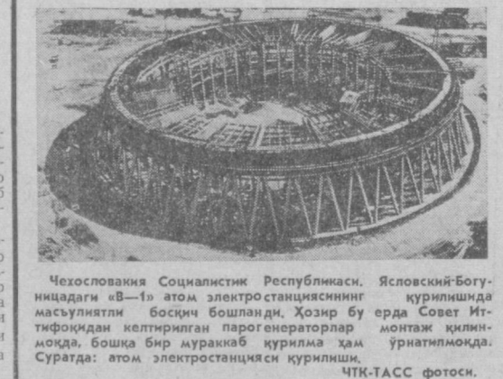
Чехословакия Социалистик Республикаси, Ясповский-Богунницадаги «В-1» атом электростанциясининг қурилишида маъсулиятли босқич бошланди. Ҳозир бу ерда Совет Иттифоқидан келтирилган парогенераторлар монтаж қилинмоқда, бошқа бир мураккаб қурилма ҳам ўрнатилмоқда. Суратда: атом электростанциясини қурилиши. ЧТК-ТАСС фотоси.
