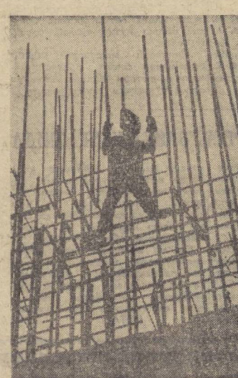
Шу кунларда Чорвоқ ГЭСининг электр станция-сини қуришида арматура иш- лари амалга ошириляпти.
