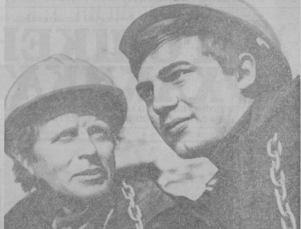
Ҳамид Олимжон номли метро станцияси яқинда 21 қаватли турар-жой биноси қўлга бун қўймоқда. «Мостжилстрот» трестининг 220-қўрилдиш бошқармаси азаматлари бионинг учинчи қаватда монтаж ишларини ижроэсга етказишга, Суратде: монтажчи Юрий Корюков ва Сергей Ивановларни кўриб турибсиз. А. Тўраев фотоси.
