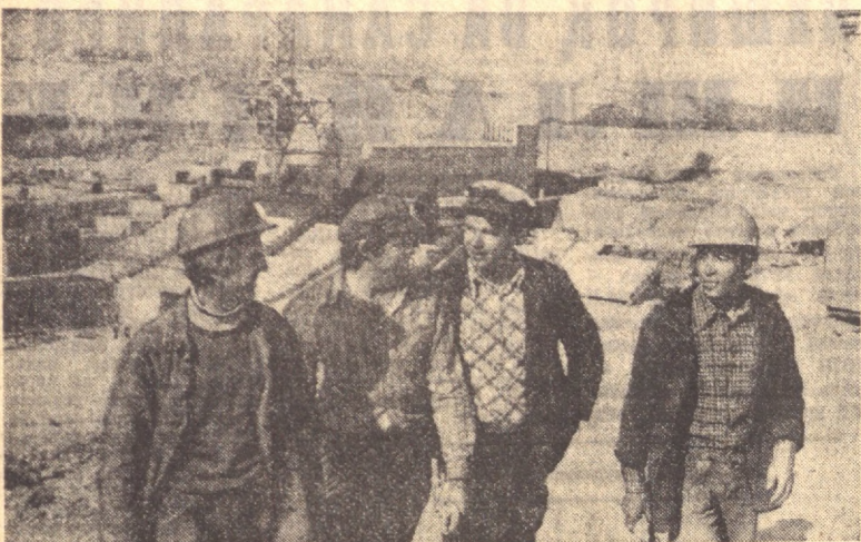
Газалент ГЭС қуруучилары станция баш корпусини бундә эттига қиришди. Қазиргача бу ерда 80 метр куб метрда әнәд бетон қиришди. Нур-хоннинг 80 метр куб метрда қуяватга ага бўлган биринчи набасти 1980 йил октябрда қиришди. Суратда: қурилишда ўрнат қуриштирилган илгор би-ноқлардан — монтажчи В. Бурцев, дурадгор Ю. Колупаев, бетончи Н. Лисак ва электр пайвандчи М. Сирлибеев. Г. Пун фотоси (ЎзТАГ).
