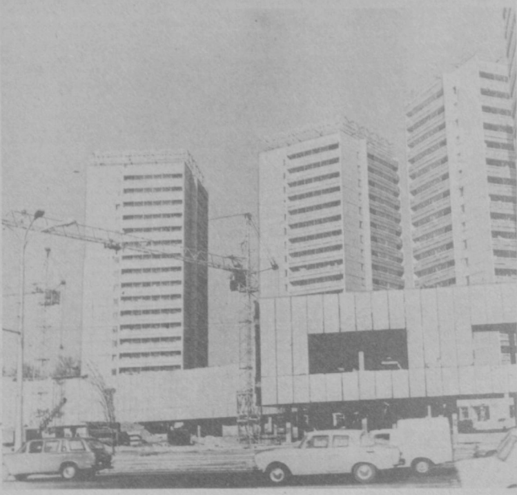
Тошкент метросининг Ҳ. Олимжон номи станцияси яқинида Ўзбекистонда энг йirik китоб растаси биноси қурилмақда. Унга «Гламострой»-га қарашли 220 қурилиш бошқармаси коллективи жадал суръатлар билан барпо этмоқда. М. Нураддинов фотоси.
